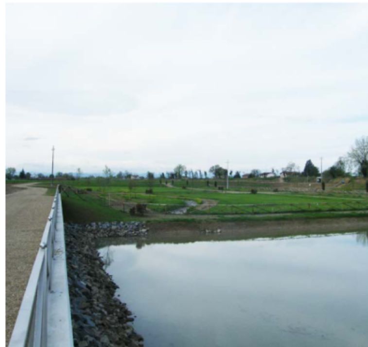
Il bacino di laminazione Lugo Ovest. A sud, invece, i lavori sono in ritardo
